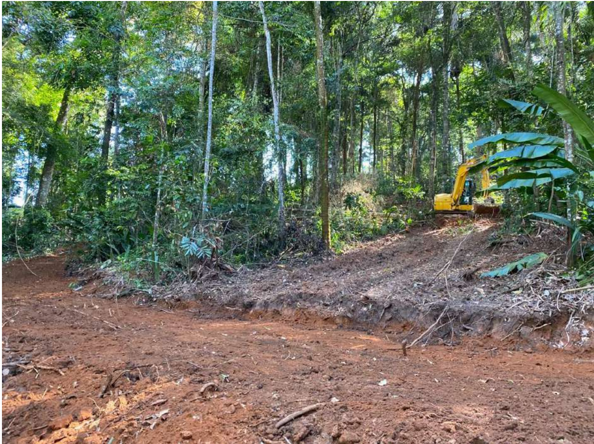
Figure 6 : Prise de vue de la réalisation des accès
