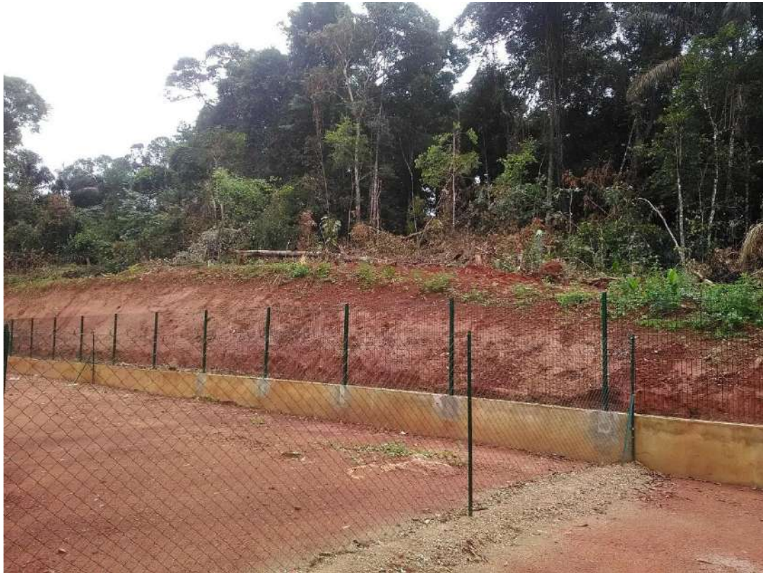
Figure 4 : Prise de vue pieds de talus situé au Nord de la parcelle
